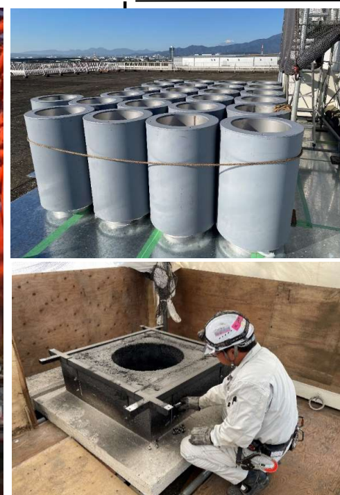
▲ 坂下さん 教会の煙突改修工事
