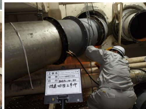
▲ 清水さん 煙道切替工事－溶接中
