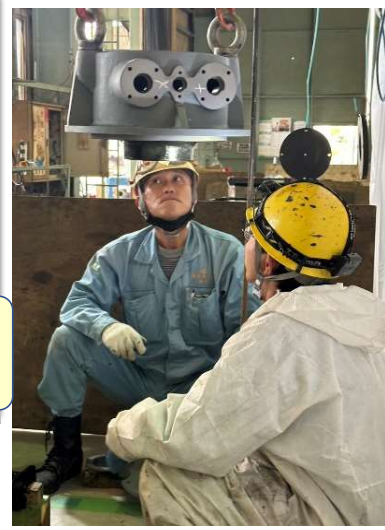
▲ ポンプの塗装は 5層塗りと4層塗りが あるそう。これは2層目。 膜厚もきっちり測定します
